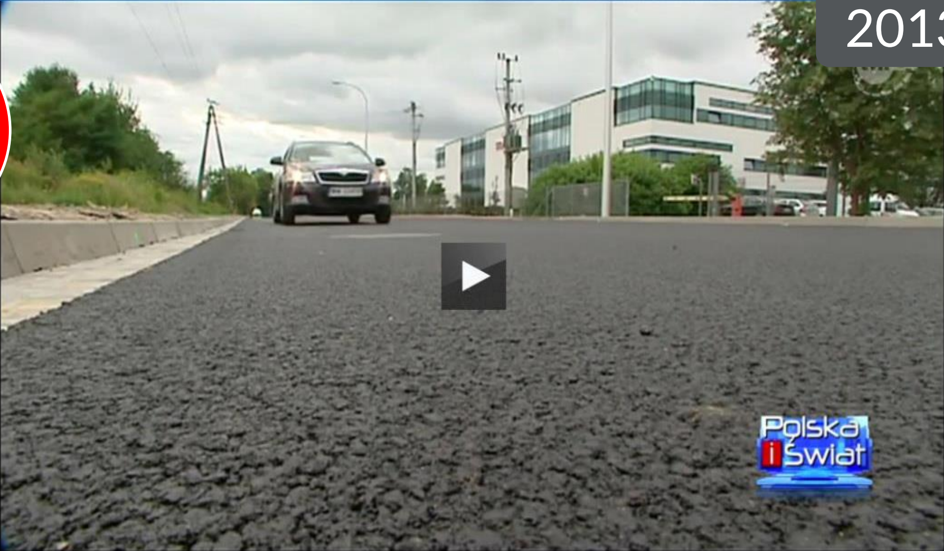
Droga z gumy 30.07 | Droga z gumy, czyli całkiem na serio wynalazek najpierw amerykańskich, potem polskich naukowców, który łączy asfalt z tym, co się po nim zwykle porusza, czyli oponami. Stare, zmielone opony dosypywane są do masy ... rozwiń
